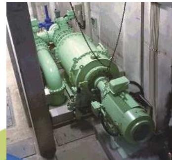
5 小水力発電システム Small hydroelectric power system 小型水电站发电系统
