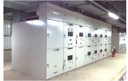
10 7.2kV メタルクラッドスイッチギア 7.2kV Metal-clad switchgear 7.2kV 金属包覆开关设备
