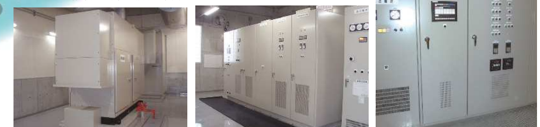
8 高速道路向け通信機能付き照明制御受変電システム Lighting control substation systems with communication function for expressways 高速公路附带通讯功能的照明控制受变电系统
