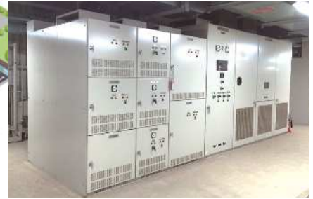
9 460V パワーセンタ 460V power center 460V 电源中心
