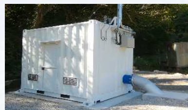
コンパクト小水力発電システム
