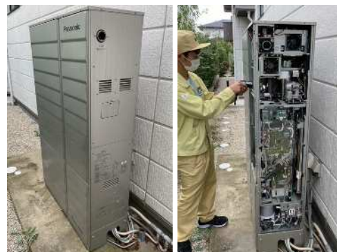
燃料電池保守点検
