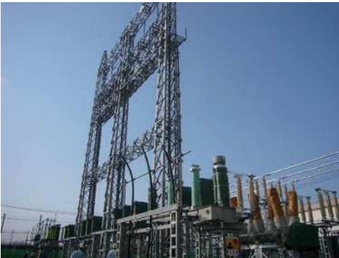
66kV変電所屋外機器設置工事
