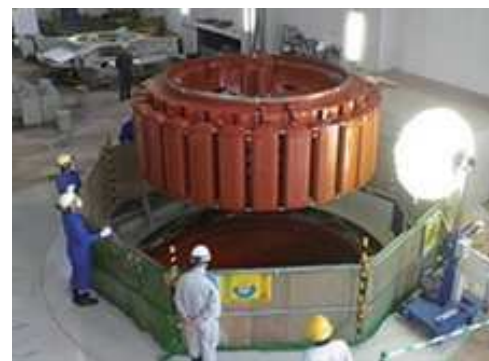
一般水力発電所解体修繕工事の発電機分解作業
