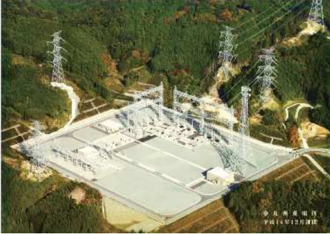
500kV変電所建設工事竣工
