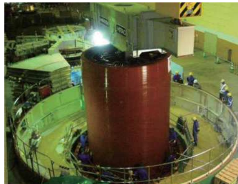
揚水発電所解体修繕工事の発電機分解作業
