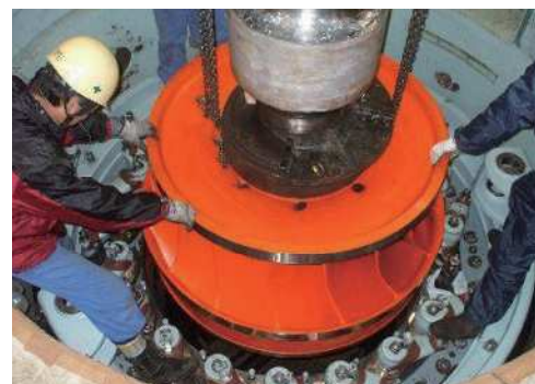
一般水力発電所解体修繕工事の水車据付作業
