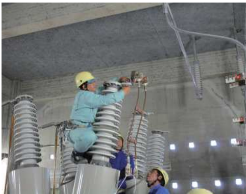
66kV全屋内変電所遮断器設置工事
