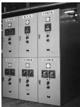
1970年 米城ビル段積閉鎖型配電盤
