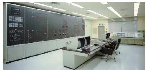
1979年 九州電力(株)中央変電所500kV監視制御システム
