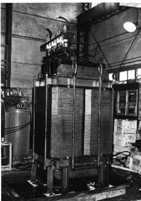
1956年 九州電力(株)健軍変電所変圧器修理
