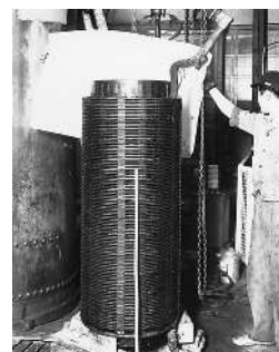
1955年 改築後の修理工場での 変圧器修理
