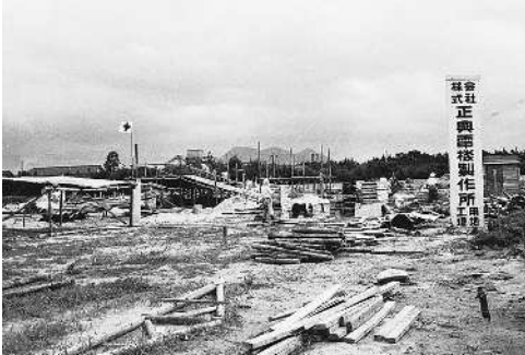
1960年 古賀工場建設用地整備
