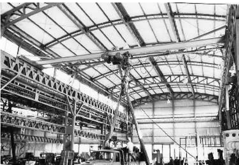
1960年10月 古賀工場竣工間際
