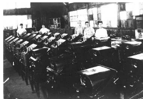
1950年 炭坑用配電函製作(日立からの受注第1号)
