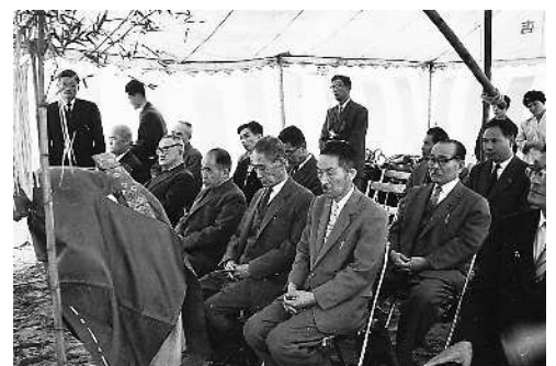
1960年4月27日 古賀工場建設地鎮祭
