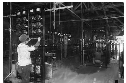
1955年頃 堅粕工場配電盤組立
