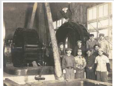
1955年 日本炭鉱(株)高松鉱業所同期電動機 修理現場
