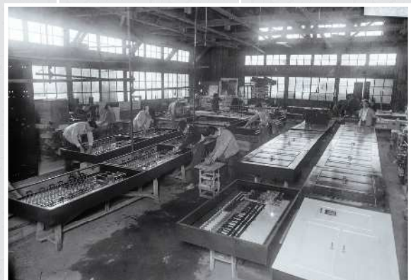
1950年頃の堅粕工場分電盤製作現場
