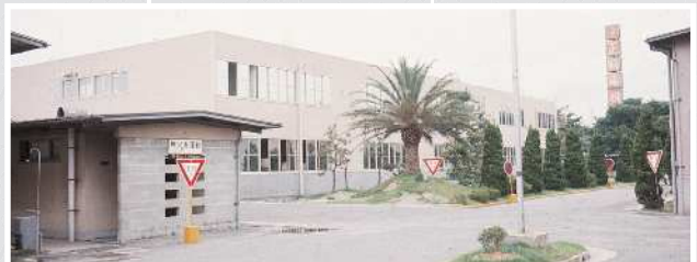
1973年 制御盤工場落成
