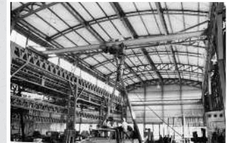
1960年10月 古賀工場第1工場建設中(ホイスト装備)
