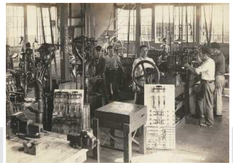
1938年当時の堅粕工場での分電盤 および部品製作現場
