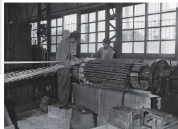
1958年 堅粕工場修理工場での変圧器修理作業
