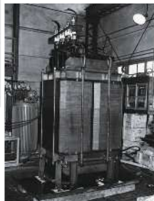
1956年 九州電力(株)健軍変電所変圧器修理完了
