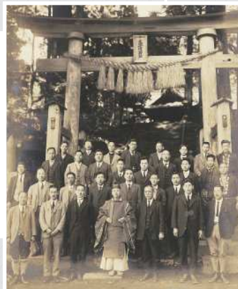
1928年 宮崎県高千穂発電所 建設工事での安全祈願
