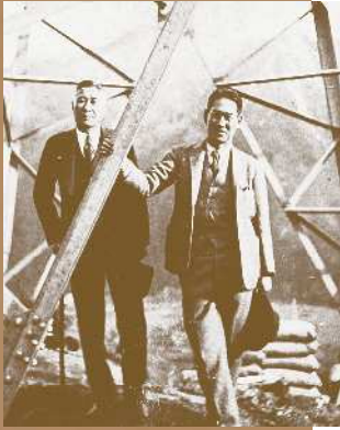
送電工事現場を視察する土屋社長
