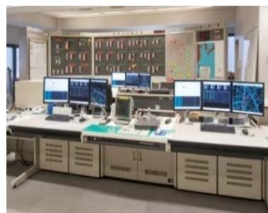
配電線の常時監視。配電機器などを自動制御し、電力の融通や停電時間を短縮。
