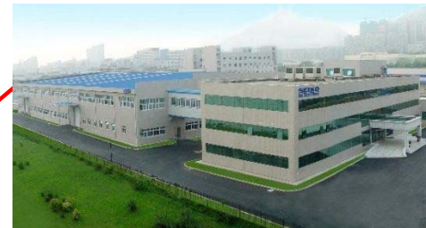
大連正興電気制御有限公司
