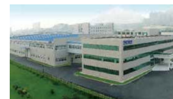
■ 大連正興電気制御有限公司
