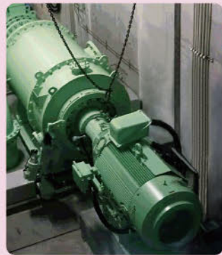
■小水力発電システム Small hydro power generation system 小型水力发电系统
