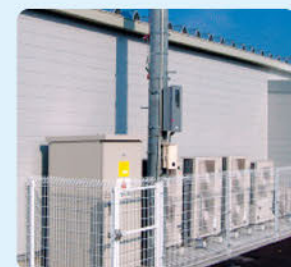
■小口高圧受電システム (コンビニ盤) High-Voltage Power Receiving Systems for Small-Hot (Distribution Board for Convenience Store) 小用口高圧受電システム (便利店用開閉器)
