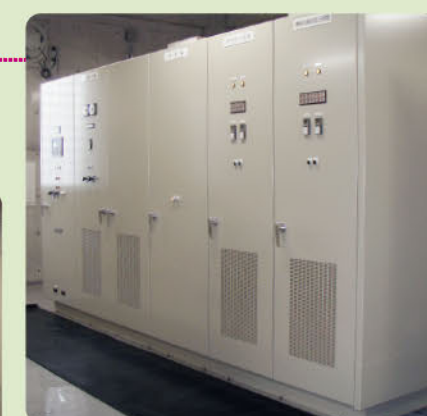
■トンネル照明用非常用発電設備・受変電設備 Emergency power system and Metal-enclosed switchgear for road lightings 隧道照明用紧急发电设备、受变电设备
