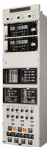
④ デジタル型保護継電器装置 (SD盤)
