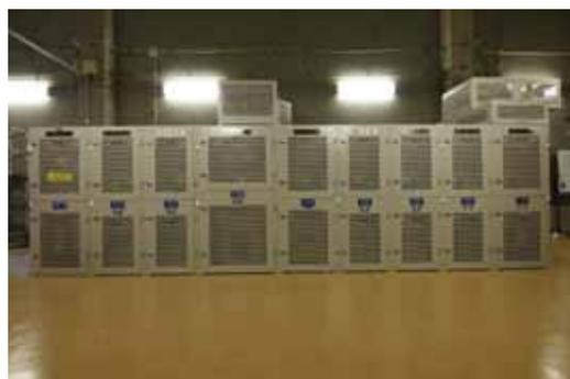
⑥ 6kV簡易配電箱（A1型アミクラ®）
