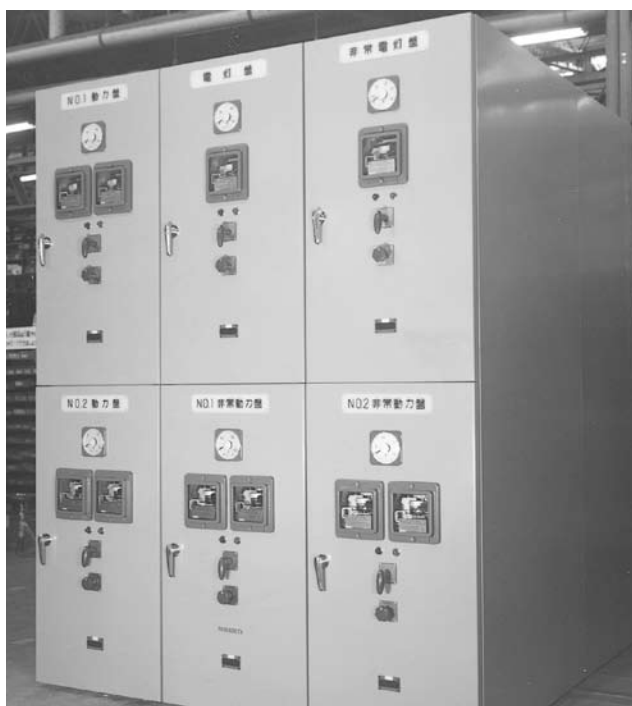
段積閉鎖型配電盤
