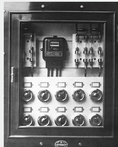
昭和11年納分電盤第1号
