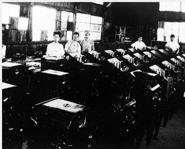
昭和24年当時の堅粕工場組み立て現場 (2)
