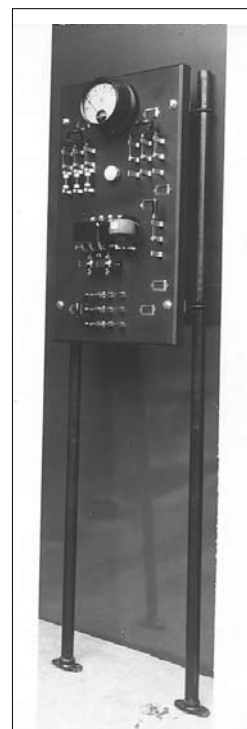
昭和25年製低圧ポンプ盤
