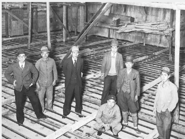
内線工事中 三井銀行新築 1階フロアダクト配管工事
