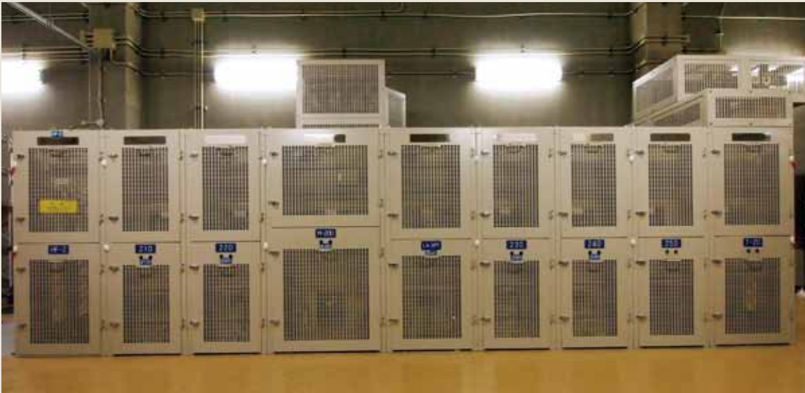
22kV enclosed switchgear (for outdoor use) 22kV 简易配电柜（室外）
