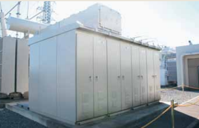
22kV enclosed switchgear (for outdoor use) 22kV 简易配电柜（室外）
