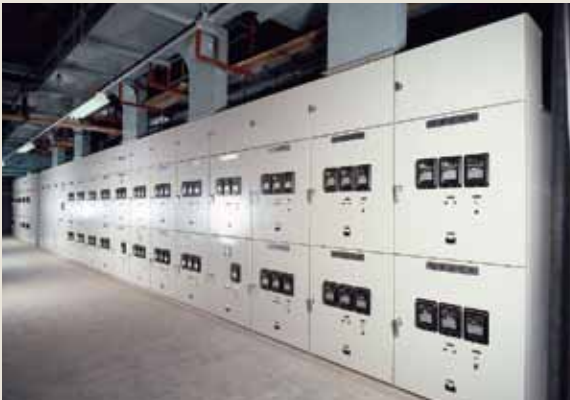
Metal-enclosed switchgear 金属铠装式高压开关柜
