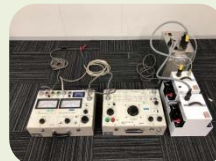
使用時接続状態 (リレー試験)
