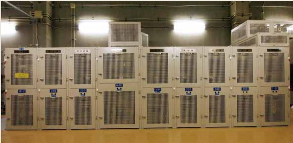
6kV簡易配電箱(アミクラ®)
